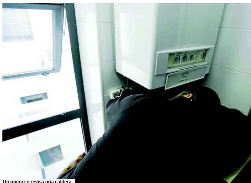
Un operario revisa una caldera.
