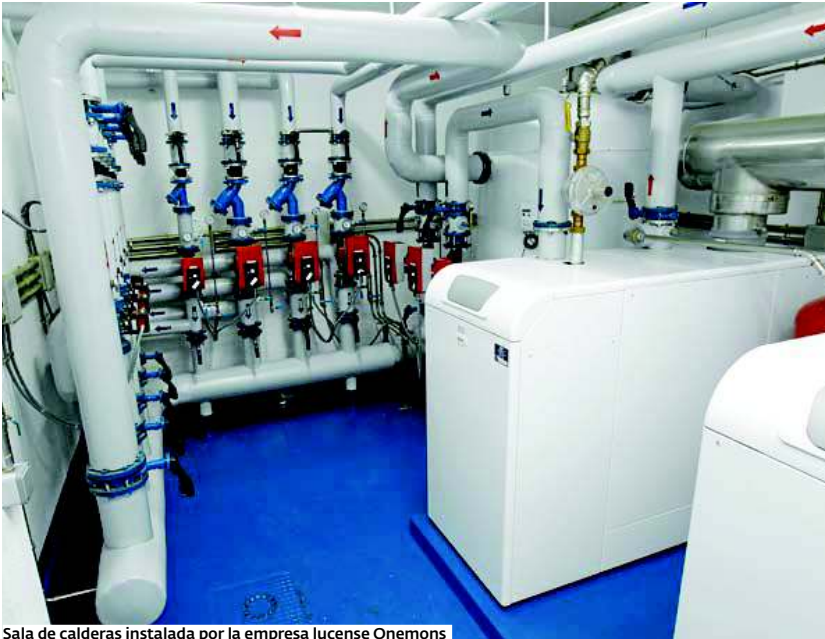
Sala de calderas instalada por la empresa lucense Onemons
