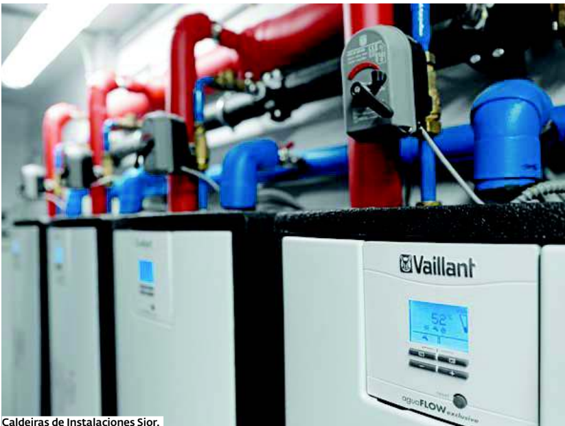
Caldeiras de Instalaciones Sior.
