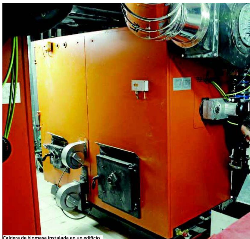
Caldera de biomasa instalada en un edificio.
