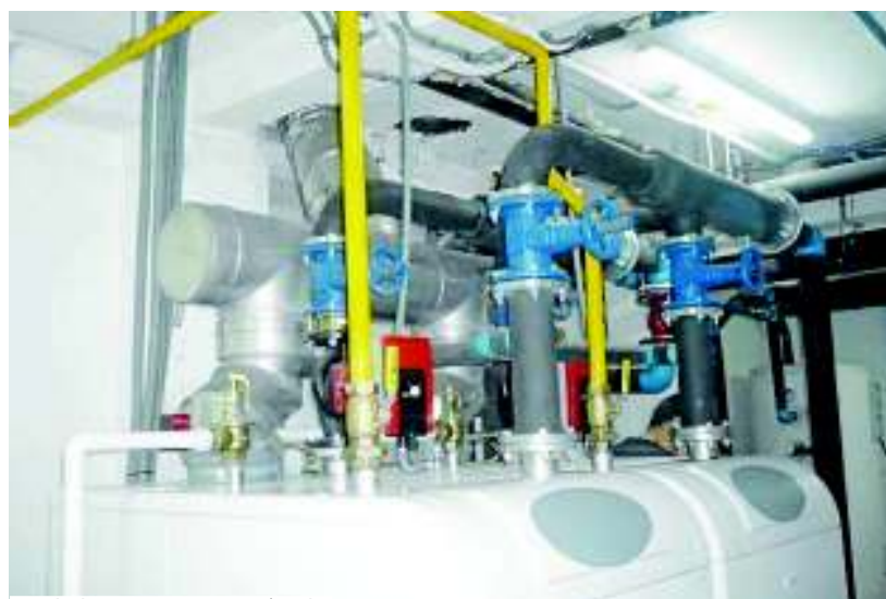
Caldeira instalada por Fontanería Rois.
